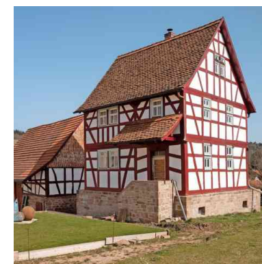
Umgezogen: Das Fachwerkhaus drohte zu verfallen, nun wurde es in Wiesen wieder aufgebaut.
